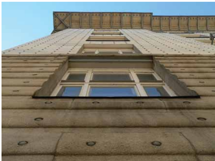
5. kép. A vékonyra vágott homlokzatburkoló kőlapok és a rögzítő csapok. A bécsi Postsparkasse részlete. (Kerékgyártó Béla felvétele)
