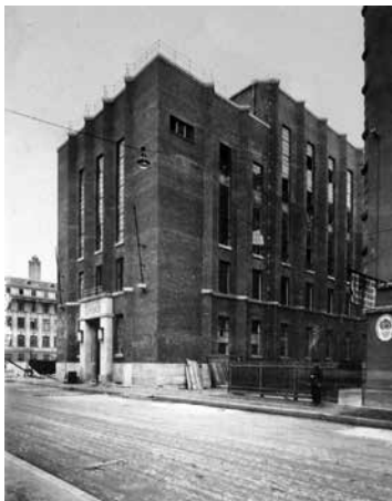
5. ábra. A Markó utcai transzformátorház északnyugat felől, 1930 (Forrás: Forster Fényképtár 16175)
