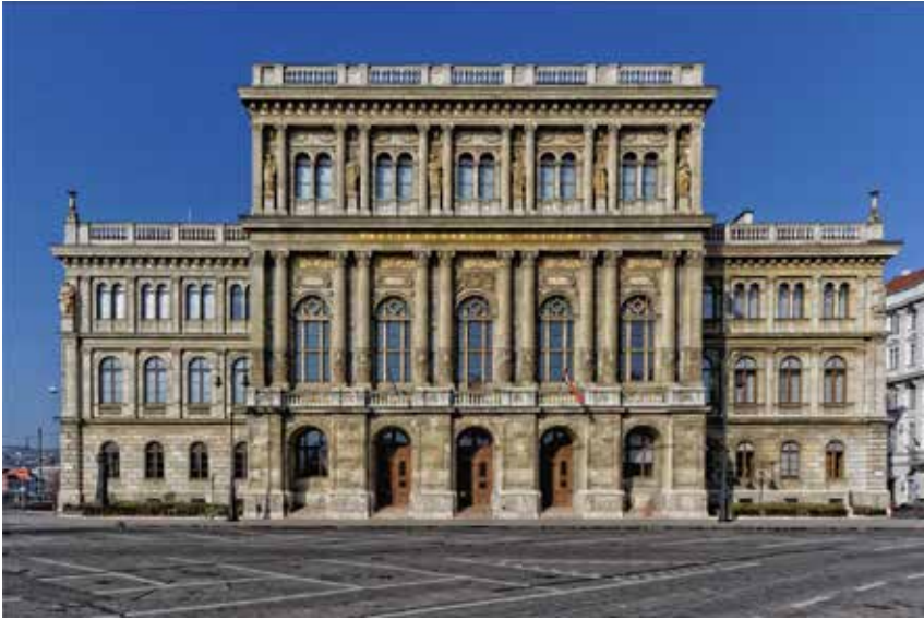
3. ábra. A palota főhomlokzata
