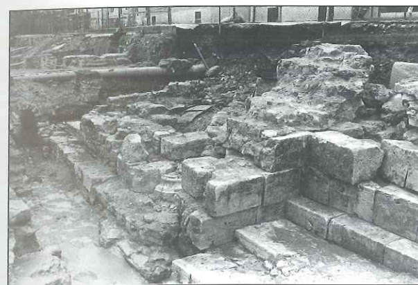
A torony délkeleti belső sarka a robbanás által elmozdított kváderkövekkel The southeast interior corner of the tower with quadrel stones moved by the explosion
