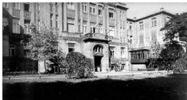
5. ábra | A jelenlegi Urológiai Klinika épülete 1922-ben
