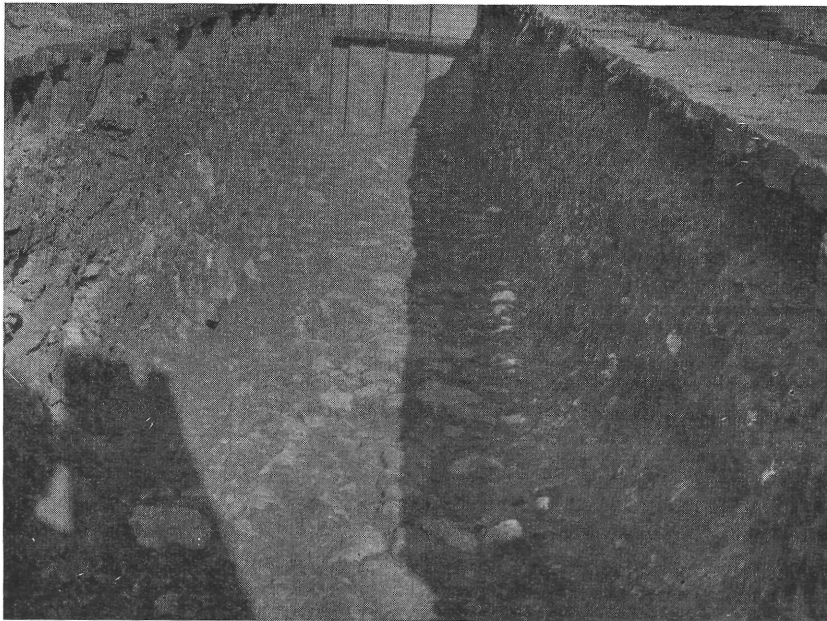
12. kép. Útburkolat a Táncsics Mihály utcából Strassenpflaster aus der Táncsics Mihály-Gasse
