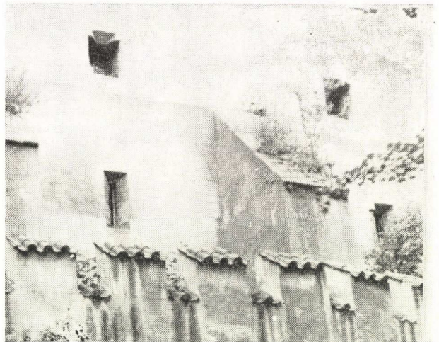
29. kép. Pisek, Csehország. Résnyílások II. Ottokár városi várának homlokzatán, 1260 körül Abb. 29. Pisek, Böhmen. Lichtschlitze an der Fassade der städtischen Burg von Ottokar II., um 1260
