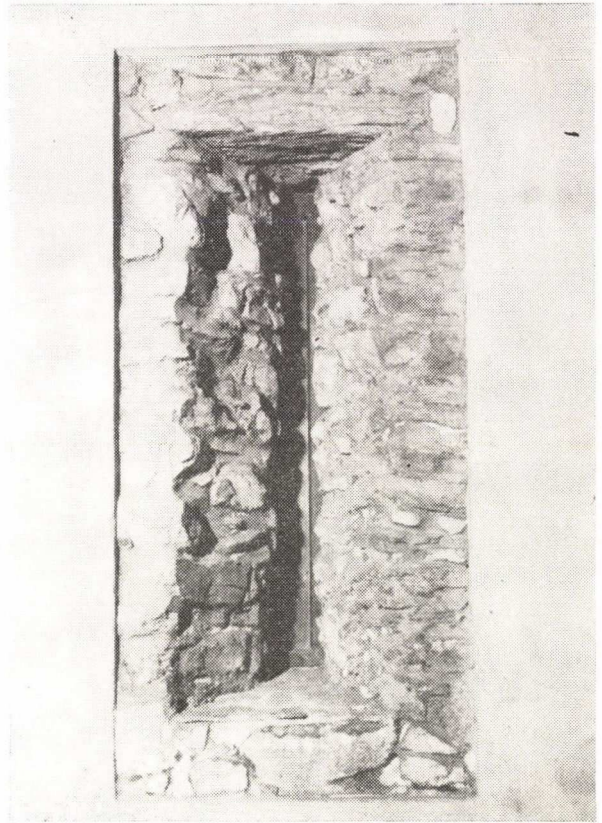
28. kép. Résnyílás a Ny-i palota földszintjén. 15. sz. Abb. 28. Lichtschlitz am Erdgeschoß des W-Palastes. 15. Jh
