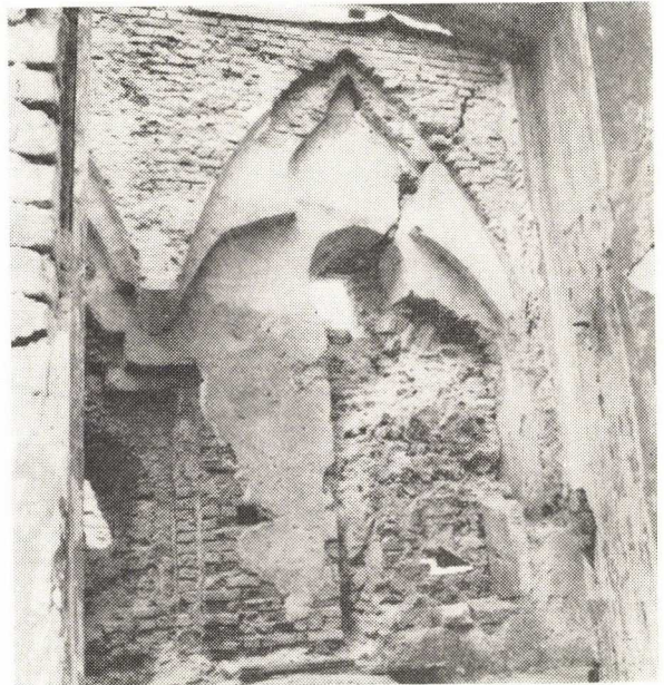
21–24. kép. Kőszeg. Az emeleti homlokzat feltárás közben. A később nyitott majd elfalazott ablakok helyei →. 23: A felirat
