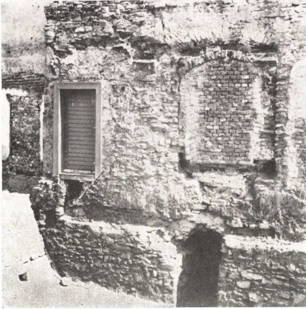
18. kép. A kőszegi palota emeletének elfalazott ülőfülkés ablaka ásatás közben
