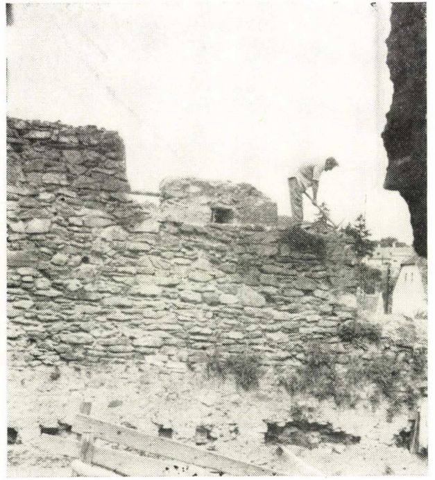
6. kép. Az É-i várfal pártázatának kibontása az elfalazásból
