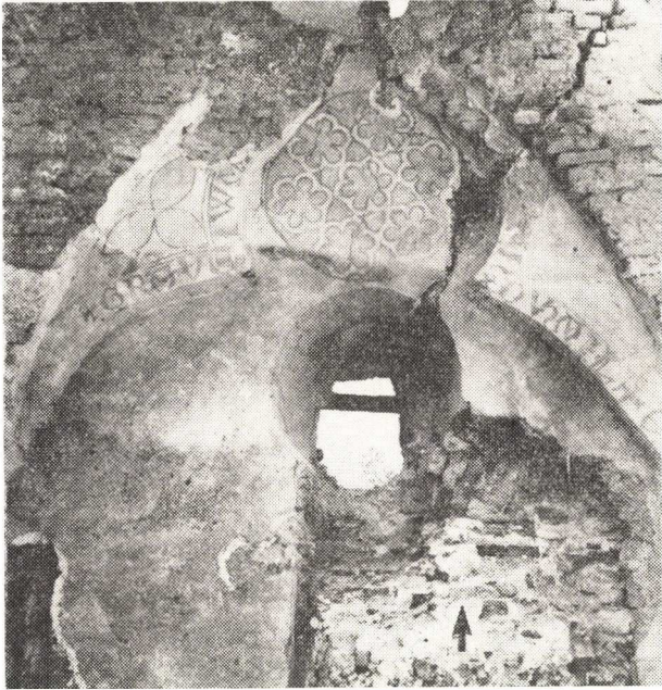
21–24. kép. Kőszeg. Az emeleti homlokzat feltárás közben. A később nyitott majd elfalazott ablakok helyei →. 23: A felirat
