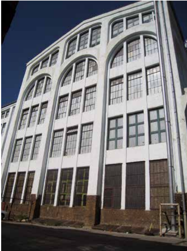
2. ábra. Vasbetonszerkezetes ipari épület. Budapest, Gubacsidűlő, 1910 (Fotó: Martin Pilsitz, 2015)
