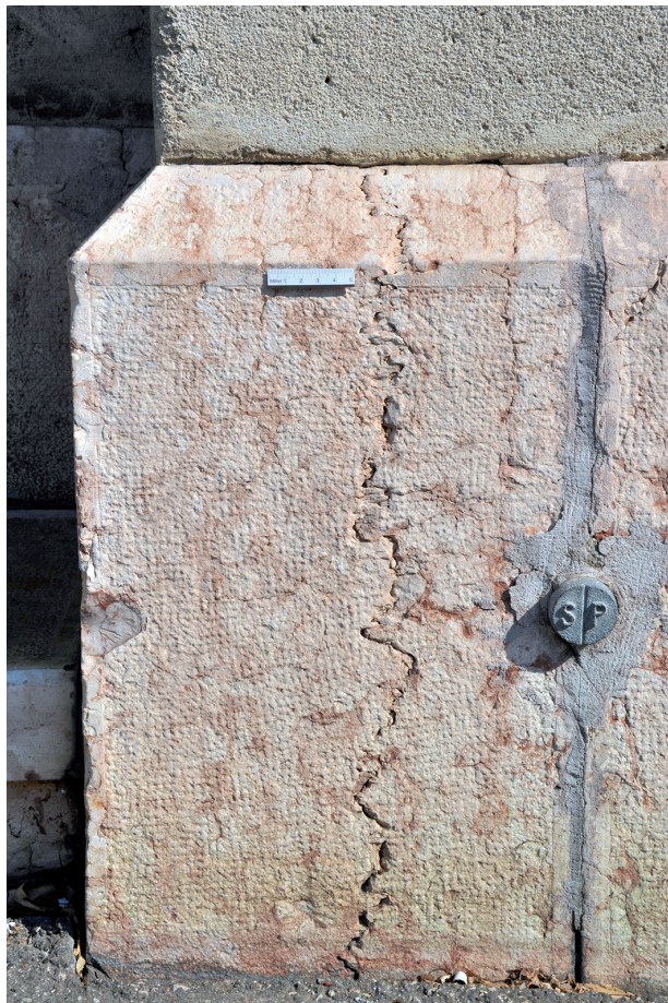
3. fénykép. A homlokzat – a kőzetnyomás következtében kialakult, oldásos eredetű, fogazott felülettel (sztilolit) tagolt – gerescei vörös mészkő anyagú alsó lábazati eleme. Fehlette durva mészkő anyagú kváderkő látszik
