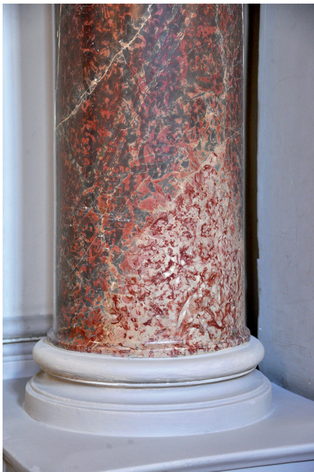
2. fénykép. Az első emeleti folyosó stukkótalapzaton álló oszlopainak anyagát az ún. „kagylós mészkő” foltos, gumós, helyenként dolomitosodott változata alkotja
