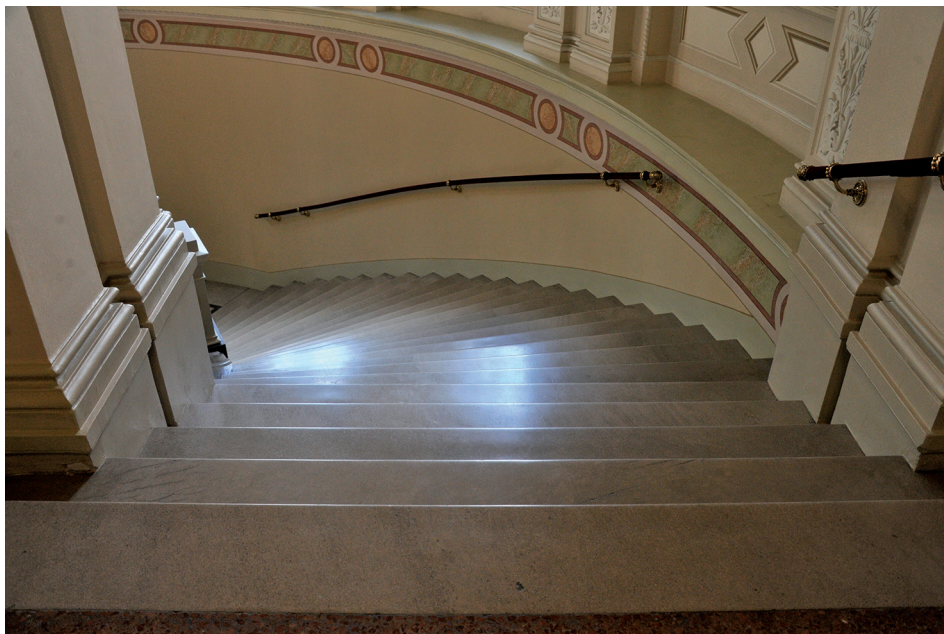
7. fénykép. A fölépcső második emeletre vezető íves szakasza. A Trieszti-öböl keleti partvidékéről származó mészkő kedvelt építőanyag volt, a kor számos építkezésénél (pl. Várkert bazár, Szent István-bazilika, Operaház) előszeretettel alkalmazták
