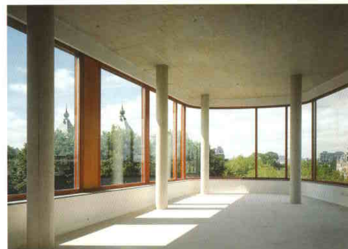
Egy csavart szelvény belülről A twisted segment from inside
