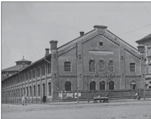
2. ábra. A Vulkán Gépgyár egyik épületszárnyának homlokzata a Váci úton
