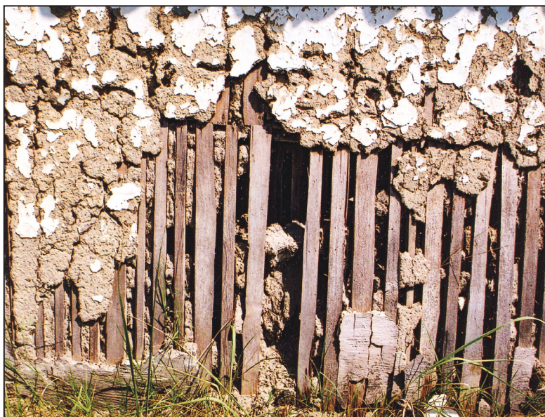
22. kép Lécvázas falazat tapasztással a Bátkában (Készítette: Mód László, Zenta, 2005.)
