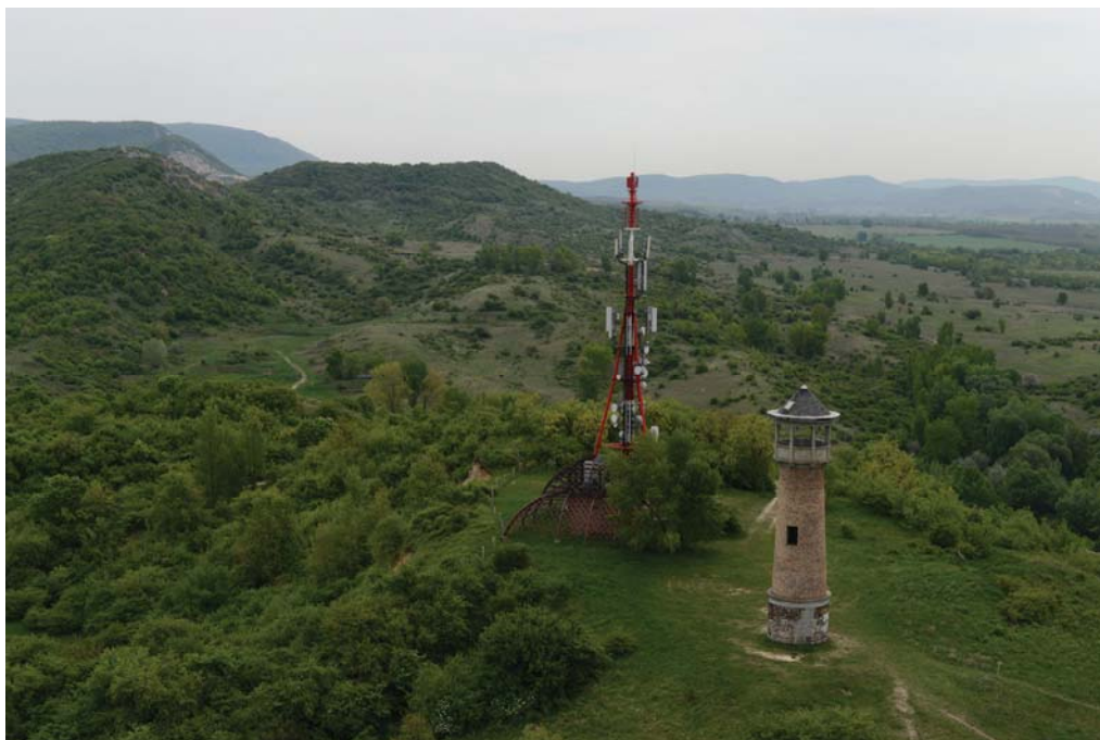
13. ábra Távközlési eszközök az esztergomi Strázsas-hegyen (a szerző légifelvétele) Figure 13. Telecommunications equipment at Strázsas-hegy hill near Esztergom (photography by the author)
