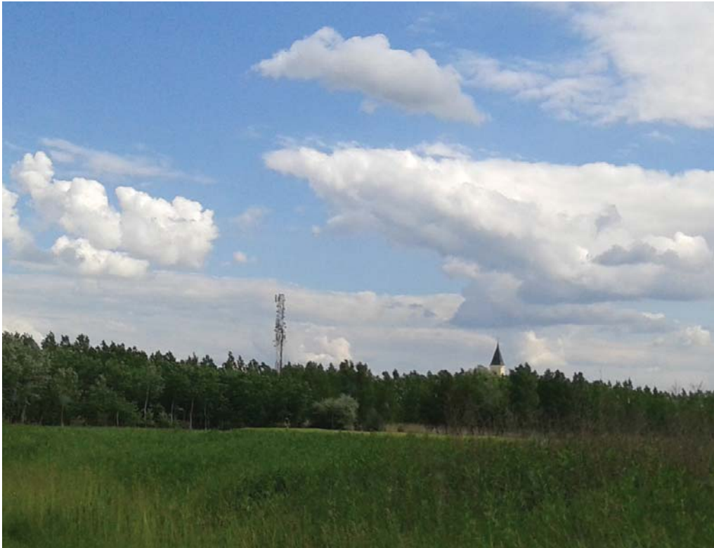
14. ábra Rácsszerkezetű távközlési torony és a falu templomának tornya Figure 14. Lattice telecommunications tower and church tower
