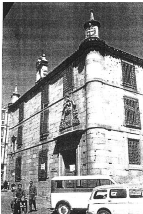
2. kép. Kőburkolatos homlokzat + tömör földszint + kis méretű bejárati kapu + rácsos ablakok + identifikációs címer + a pozitív sarkok hangsúlyozása = a környezettől való elzárkózás, védelem. – Segovia, levéltár
