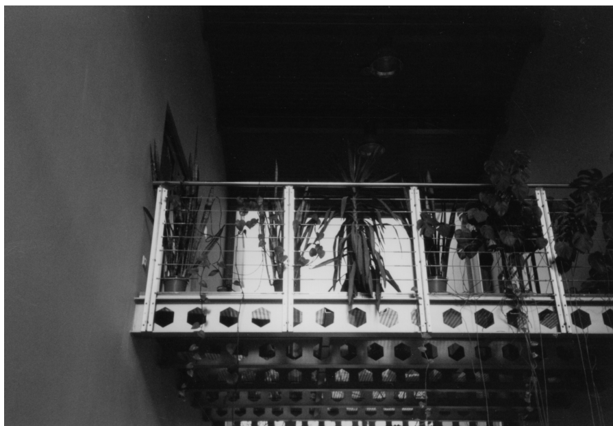
12. ábra. Üveghíd mint transzparens összekötő szerkezet a Bécsi Műszaki Egyetem Építőanyagtanai, Épületfizikai és Tűzvédelmi Intézetének laboratóriumi és intézeti épülete között (a szerző felvétele)
