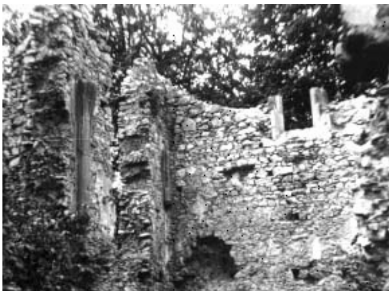
19. ábra. Dédes, pálos kolostor, a hajó támaszrendszere és boltozati indítása (fotó: Guzsik, 1965)
