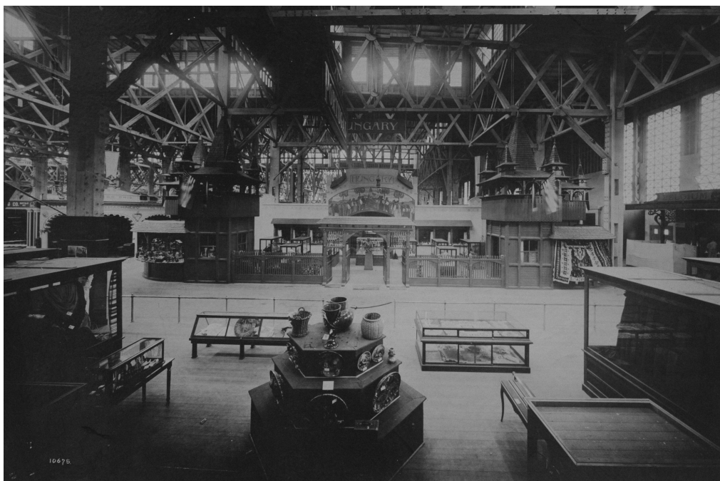
84. kép. Horti Pál pavilonja a Manufactures csarnokban
