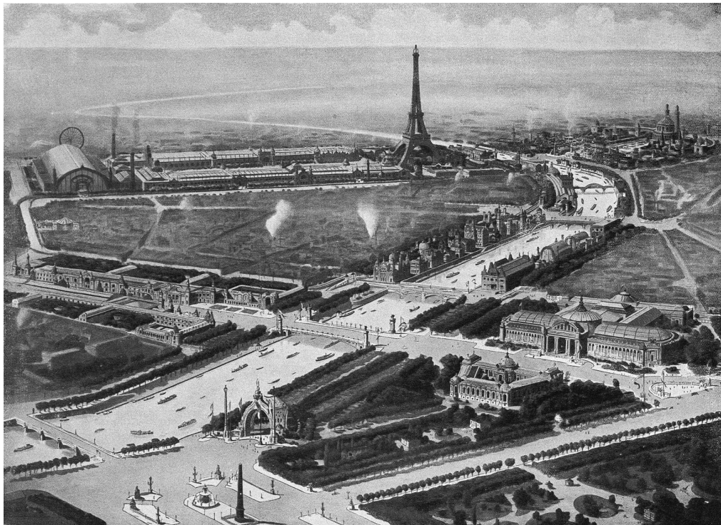
49. kép. Az 1900-as párizsi világkiállítás összképe
