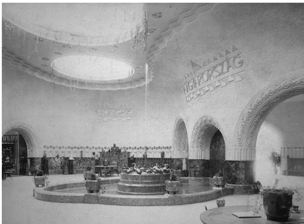
93. kép. A Maróti Géza tervei alapján készült díszterem a milánói magyar enteriőr-pavilonban
