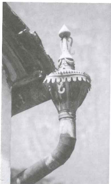
Díszes vízgyűjtő Verzierung des Wasserrohres
