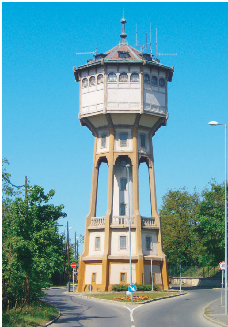
23. A sváb-hegyi víztorny az Eötvös úton 23. The water tower of Sváb Hill in the Eötvös Street
