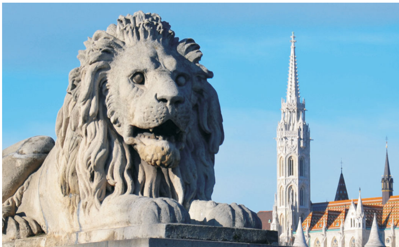
29. A Lánchíd oroszlánjait szarmata durvamészkből faragták, míg a háttérben feltűnő Mátyás-templom külső kőanyaga édesvízi mészkő 29. The Chain Bridge Lions are made of Sarmatian porous limestone, the exterior cladding of Mathias Church is made of travertine
