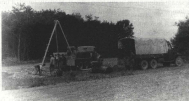
34. ábra. Lyukkezelési művelet a „vitlával” szeizmikus robbantás előkészítésére valahol Zalában az 50-es években
