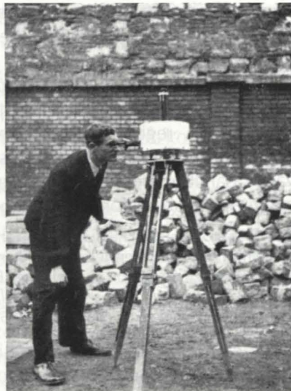
Haáz István a Kohlrausch-féle horizontális variométerrel
