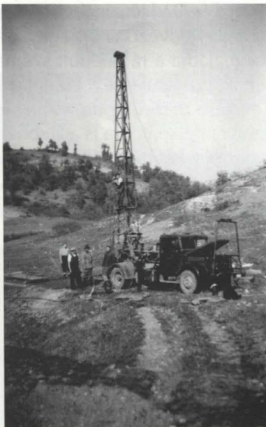
37. ábra. Robbantási pont fúrása
