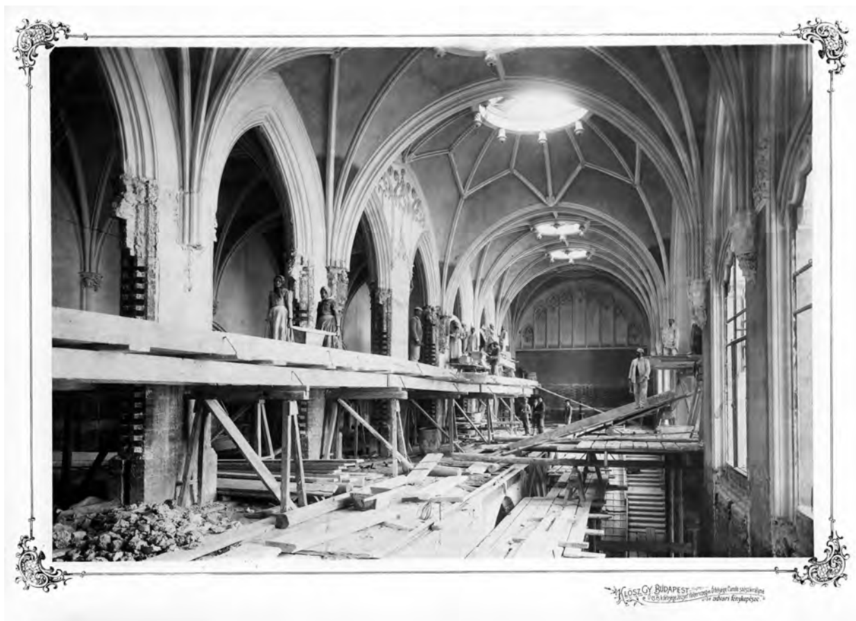
7. Az előcsarnok főlépcsőháza építés közben. Klösz György felvétele (1903) (Fortepan/Budapest Főváros Levéltára, XV. 19. d. 1.01.001)
