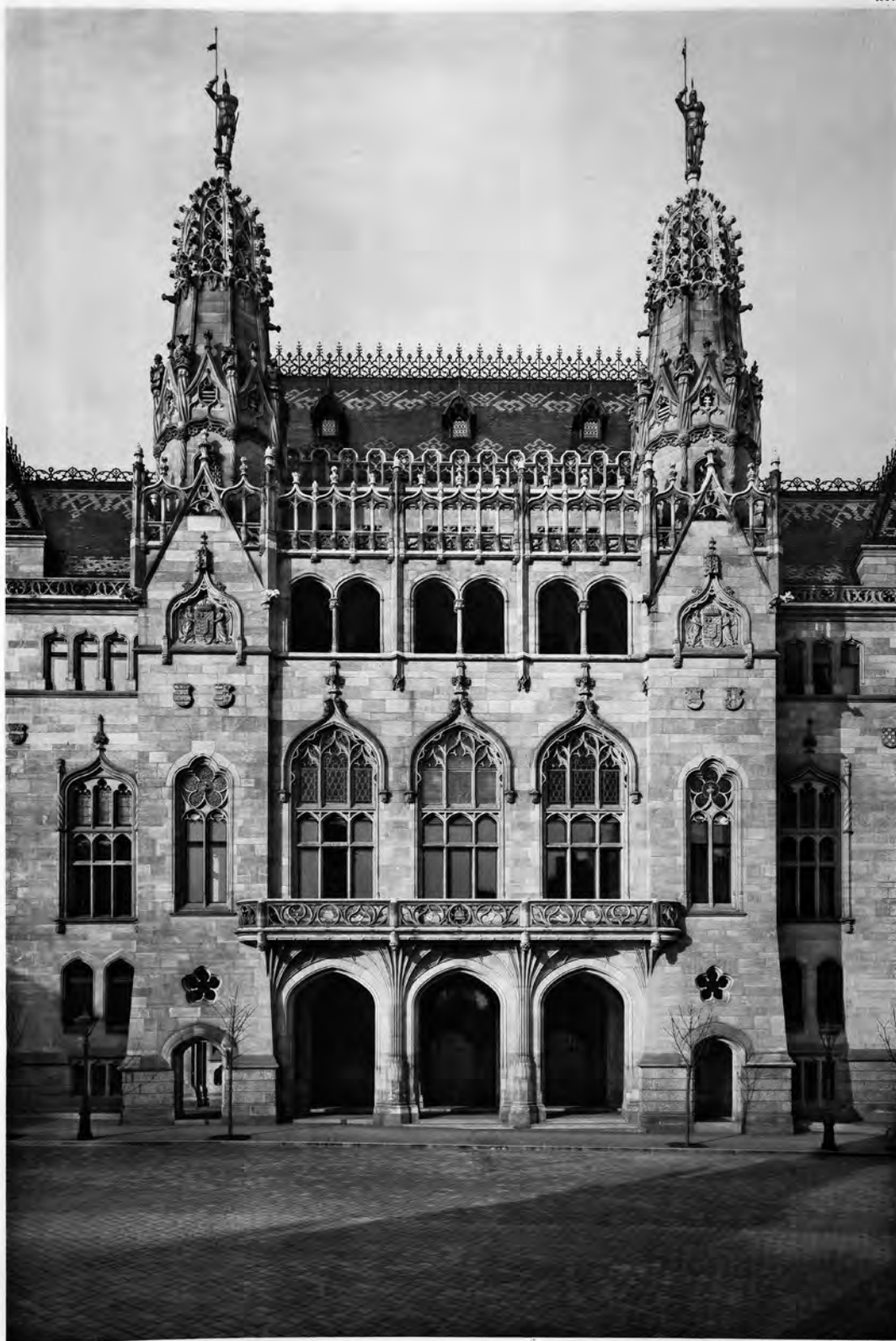
Főhomlokzat részlete. — Vue partielle de la façade principale. — Detail der Hauptfacade.
