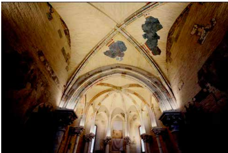
8.a ábra. Esztergom, palotakápolna, belső restaurálás után
