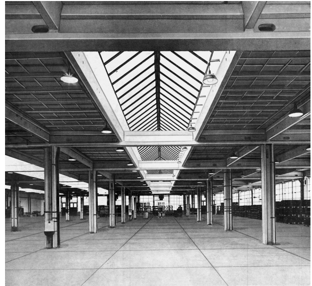
15. A Mechanikai Mérőműszergyár típusszerkezetű üzemi csarnoka, Szekszárd. 1960–1965. Adaptáló tervezők: Bokor Mihály, Kovács Tibor, Heffer János, Steiner Imre. Forrás: Katona József szerk.: Építésiparosítás, műszaki tervezés, tipizálás. Típustervező Intézet, Budapest 1969, 150.
