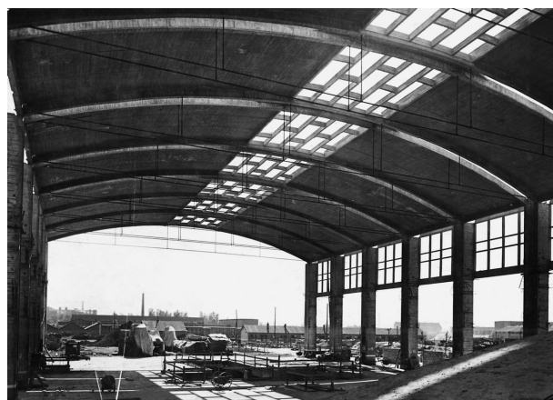
12. A Kábel- és Sodronykötélgár üzemi csarnoka, Budapest. 1960–1962. Tervezők: Mátrai Gyula, Pászti Károly, Nagy Arisztid. Forrás: (Modern) (Ipari) Építészetért Alapítvány – IPARTERV Fotóarchívum, No. 5466
