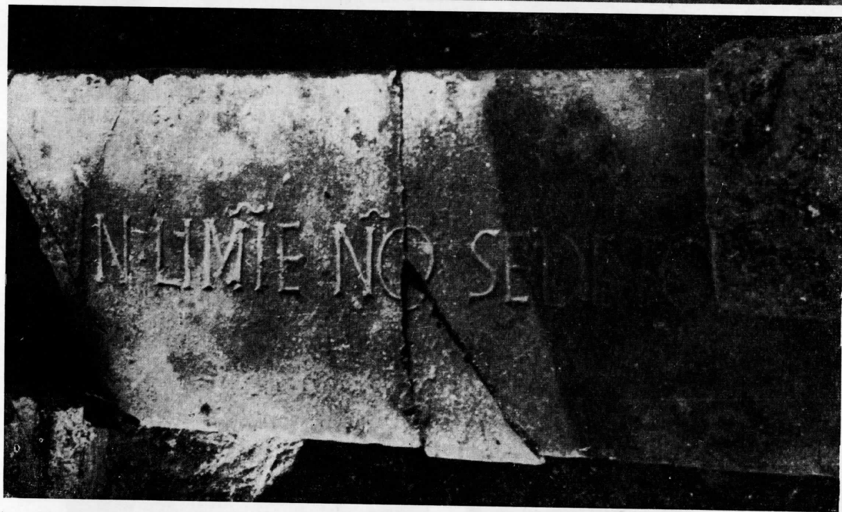
1. Ursprünglicher Haupteingang der Kapelle; 2. Der Schwellstein des Haupteinganges mit lateinischer Inschrift (Aufnahme von J. Molnár)
