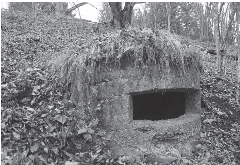
10. kép Betonból készült lövészállás a Felső-Maros-áttörésben Szalárd közelében Forrás: a szerző saját felvétele
