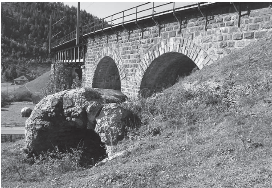
1. kép Felrobbantott lövészállás a gyimesfelsőlaki vasúti híd mellett.
