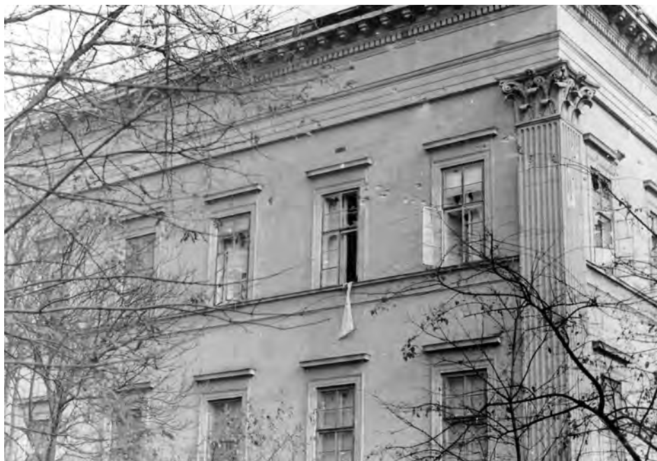
11. ábra. Lövésnymok az MNM Múzeum körüti homlokzatának jobb oldalán, az ásványtári kiállítás termeinek (az 1a ábrán AK2–AK3) részben betört ablakaival
