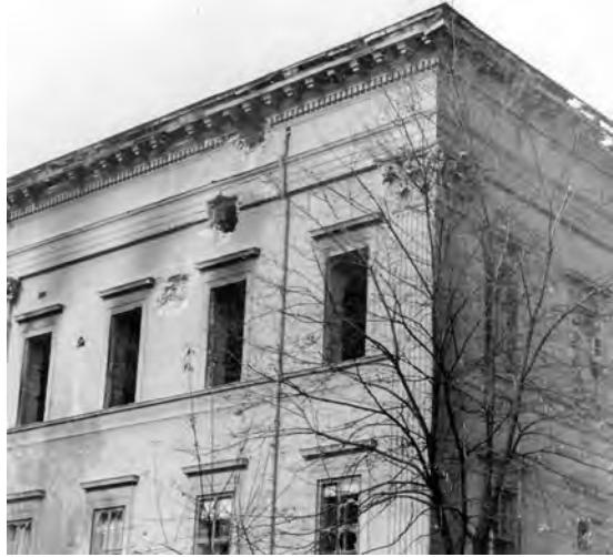
12. ábra. Az MNM Múzeum utcai (balra) és Pollack Mihály téri homlokzatának sarka tankágyú lövésnyomokkal. A saroktól balra a második ablak (az ásványtári adminisztrátor szobája, az 1a ábrán ÁT5) fölött az Afrika-kiállítás „krokodilos termét” szétromboló lövedék behatolási helye látható
