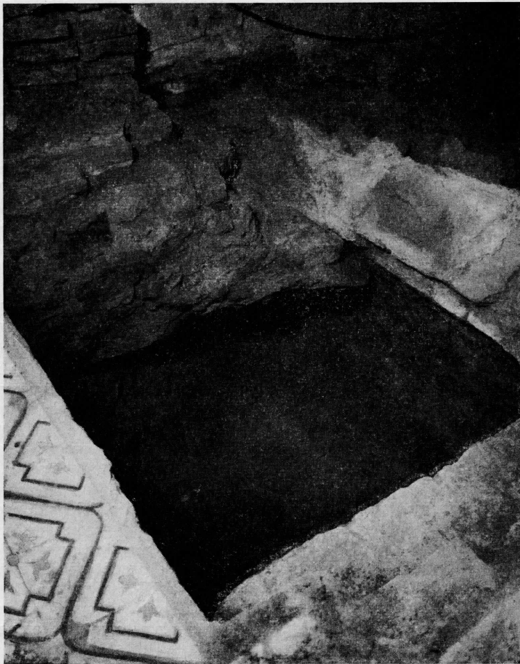
7. kép. A kerengő XV. századi falának alapozása a pince elbontott boltozatára támaszkodik.
