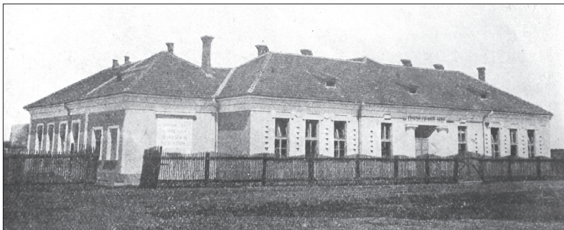
1. kép. A szvobodai iskola épülete 225
