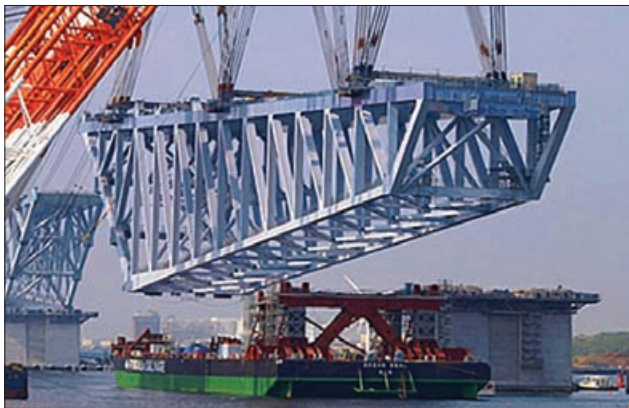
2. ábra: Tokyo Gate Bridge építése [1]
