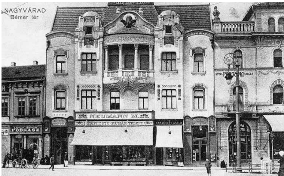
16. ábra. A nagyváradai Központi Takarékpénztár épülete. Nagyvárad, 1907 (képeslap)
