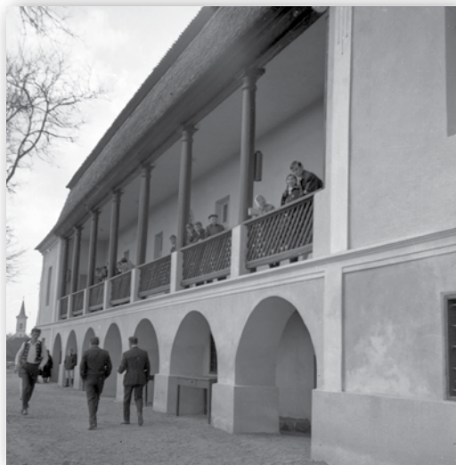
A székelytamásfalvi Thúry-kúria felújítás utáni megnyitása. 1973, SzNM Fotótéka (KA)
