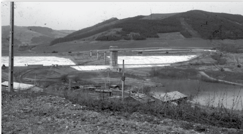
Épül a bözödújfalusi víztározó gátja. 1988. október 22. (PL)
