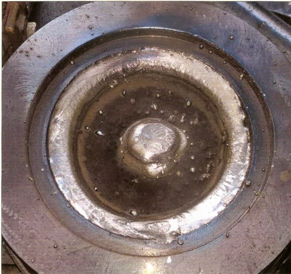
4. ábra. A felső szerszámfél hegesztés közben
