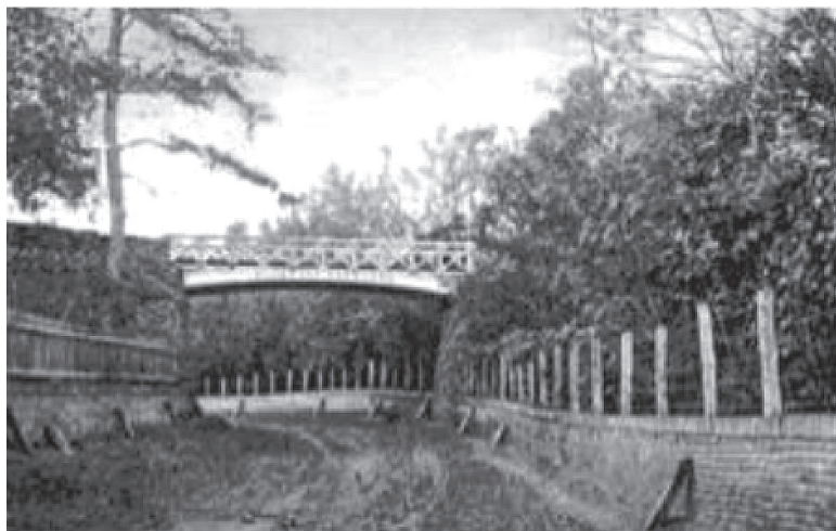
5. kép. A Mály út fölött átívelő fahíd
