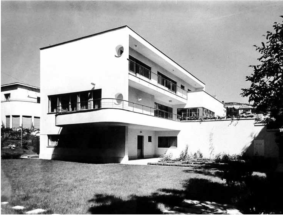
7. ábra. Szakáts Lajos villája, Budapest II., Pasaréti út 97. 1933–1934 (ismeretlen fényképész, feltehetően MFI, magántulajdon)
