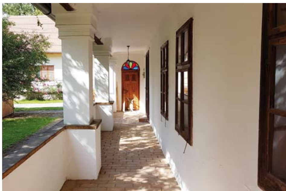
A tanítólak felújított verandája
