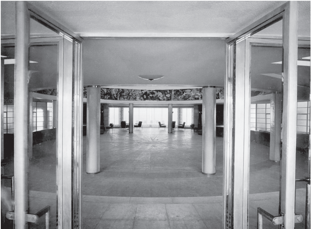
Fig. 35. The waiting room of Budaörs Airport's terminal building (photo: Mrs Elemér Marsovszky, Belvárosi Fotóműhely, 1937; MÉM Borbíró-hagyaték GYN: 659. 21. doboz)
