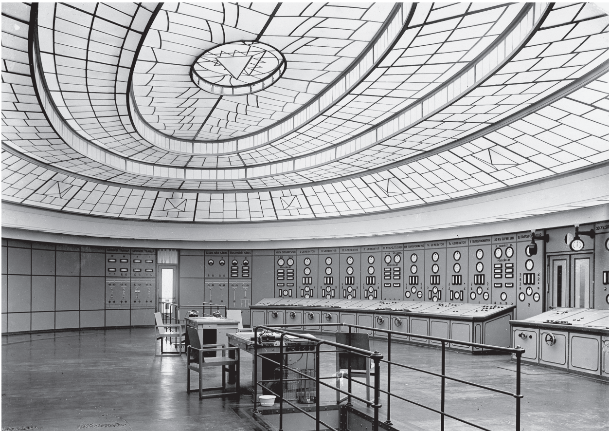
Fig. 17. The control room of Kelenföld Power Station, architect: Virgil Bierbauer, 1927–1933 (photo: Tivadar Kozelka; MÉM Borbíró-hagyaték GYN: 659. 22. doboz)
