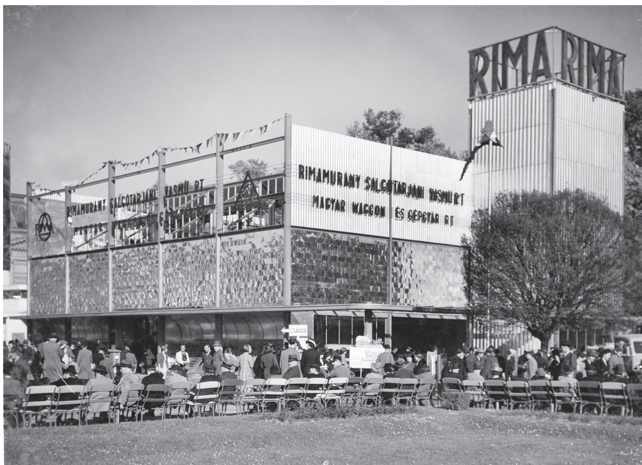
Fig. 13. Pavilion of the Rimamurány–Salgótarján Ironworks at the Budapest International Fair, architect: Virgil Bierbauer, 1939–1941; on the façades montages by Mrs Elemér Marsovszky, 1939 (MÉM Borbíró-hagyaték GYN: 659. 22. doboz)
