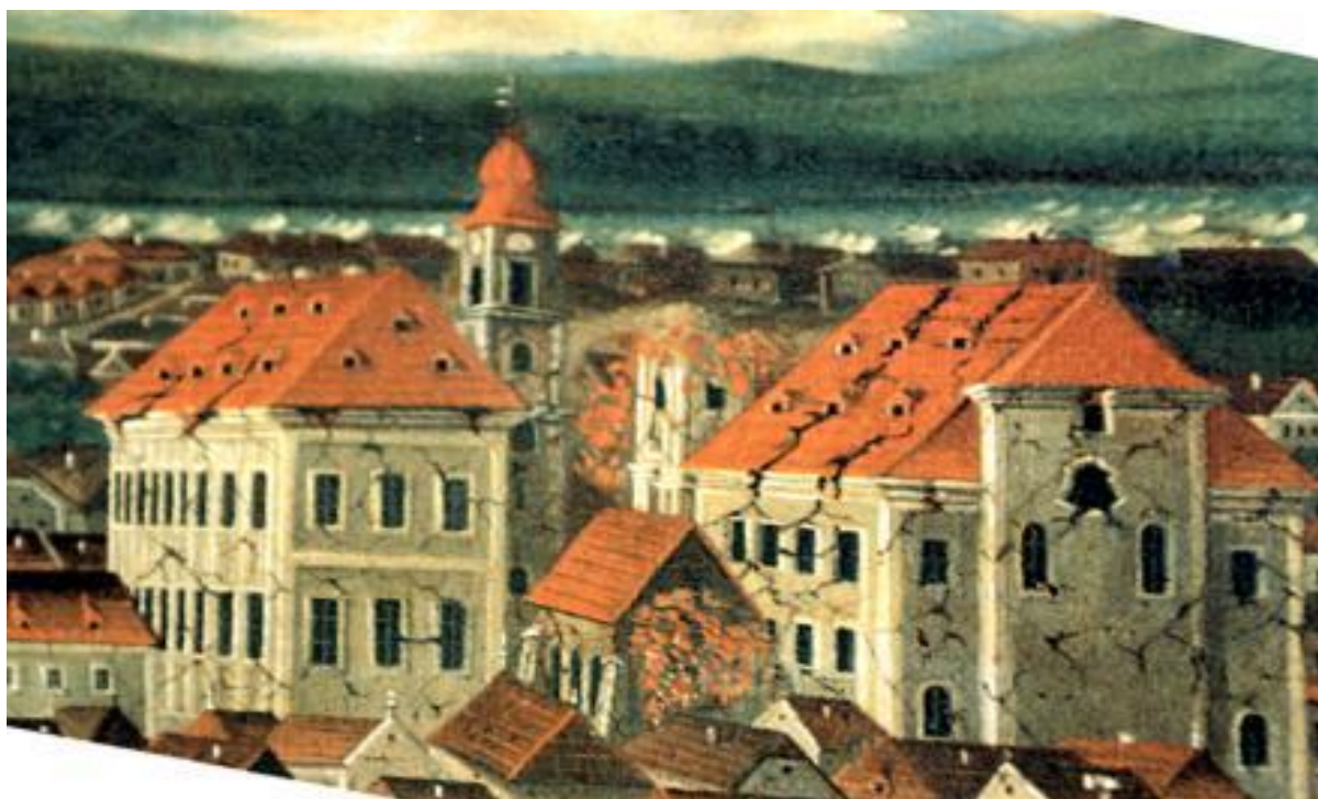
Komárom az 1763-as földrengést követően (korabeli ábrázolás)
