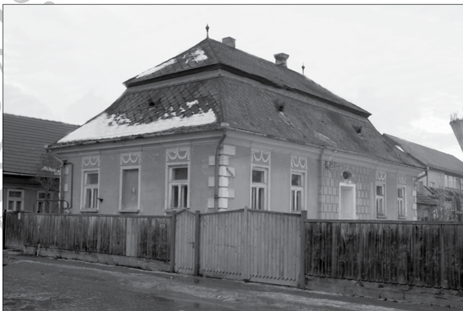
Nagy Jáfet nyugalmazott császári és királyi főhadnagy református egyháznak adományozott háza a mai Vasút utcában. (Dimény Attila, 2013)
