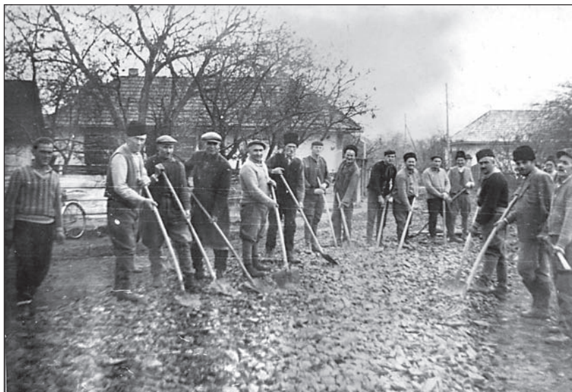
3. kép. Útépítési közmunkán
