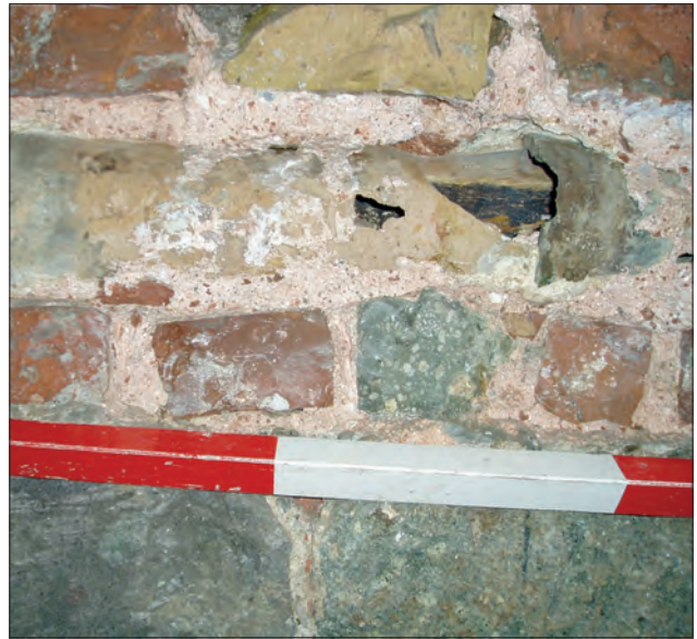
62. kép. A Rudas fürdő falában feltárt török kori kerámia vízvezetékcsövek
