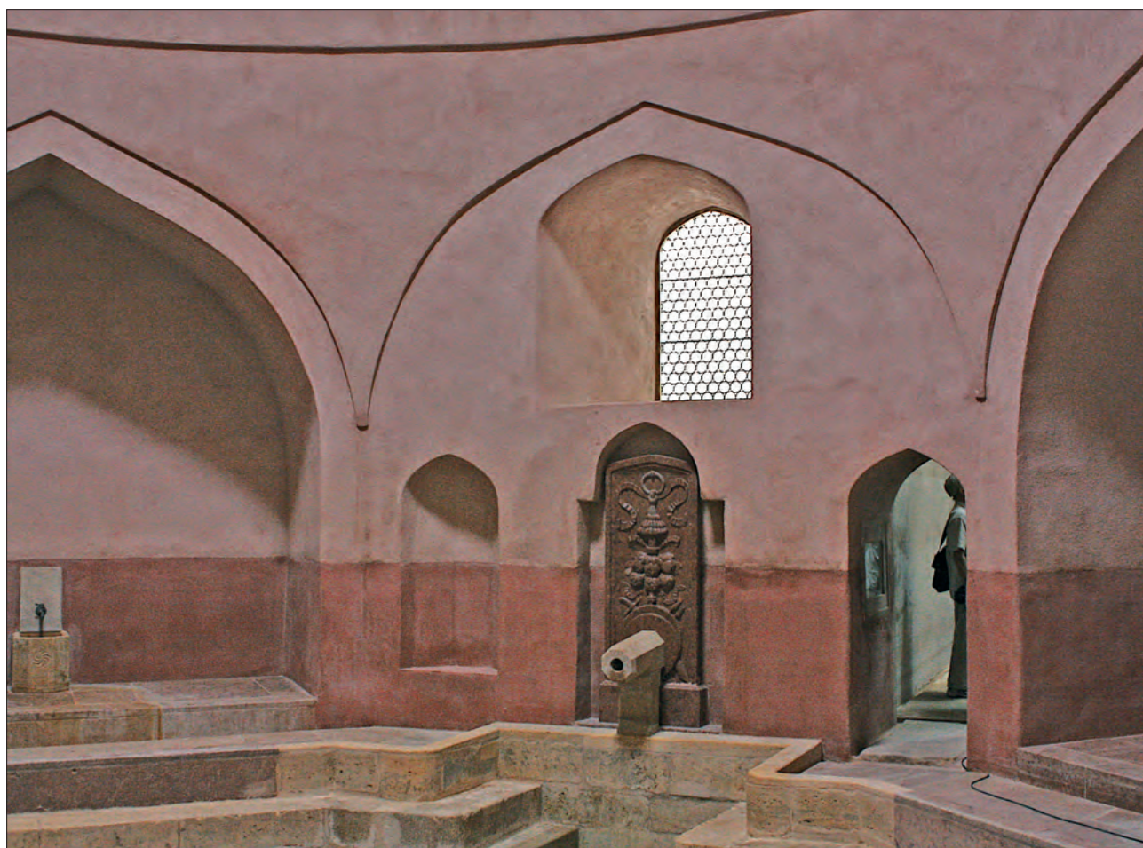
94. kép. A Rác fürdő forró terme helyreállítás után
