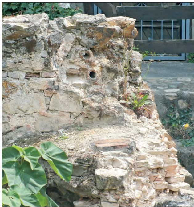
111. kép. A székesfehérvári ikerfürdő falában látható vízvezetékcsövek
