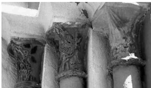
Abb. 114. Neustadt-Burzenland, Pfarrkirche, Westportal, südliches Gewände
