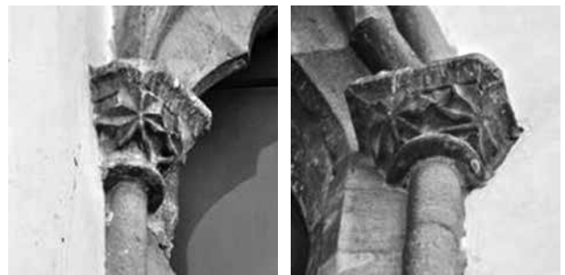
Abb. 120–121. Bistritz, Minoritenkirche, Westfassade, Maßwerkfenster, Gewändekapitell (vgl. Abb. 119)
