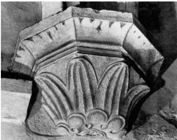
Abb. 108. Mühlbach, Pfarrkirche, Konsole des Mittelschiffsgewölbes (VARGA 1984, Abb. 29)
