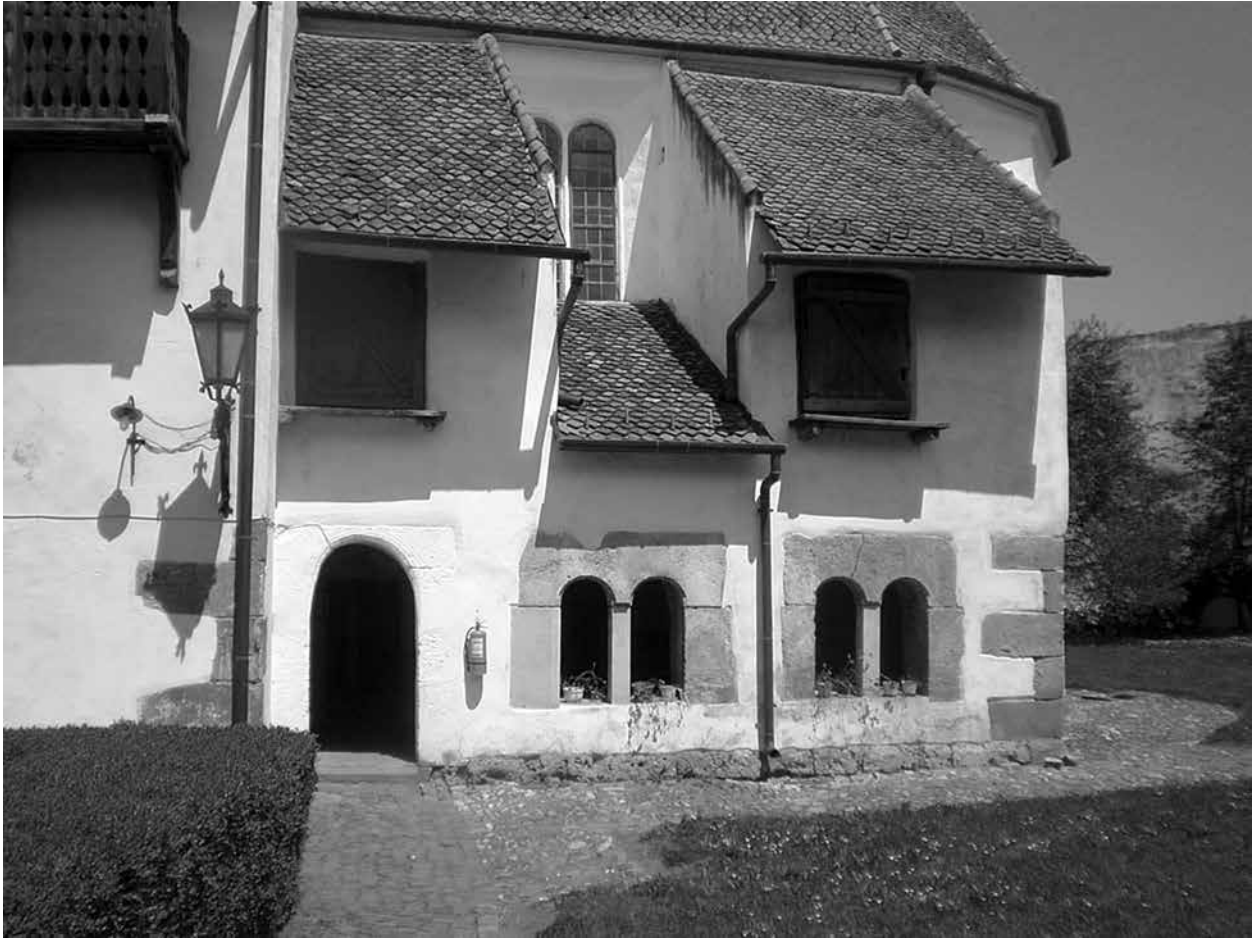
Abb. 99. Honigsberg, Pfarrkirche, Ansicht der Ostpartie von Süden (Budapest, Planarchiv des ehemaligen Denkmalamtes)
