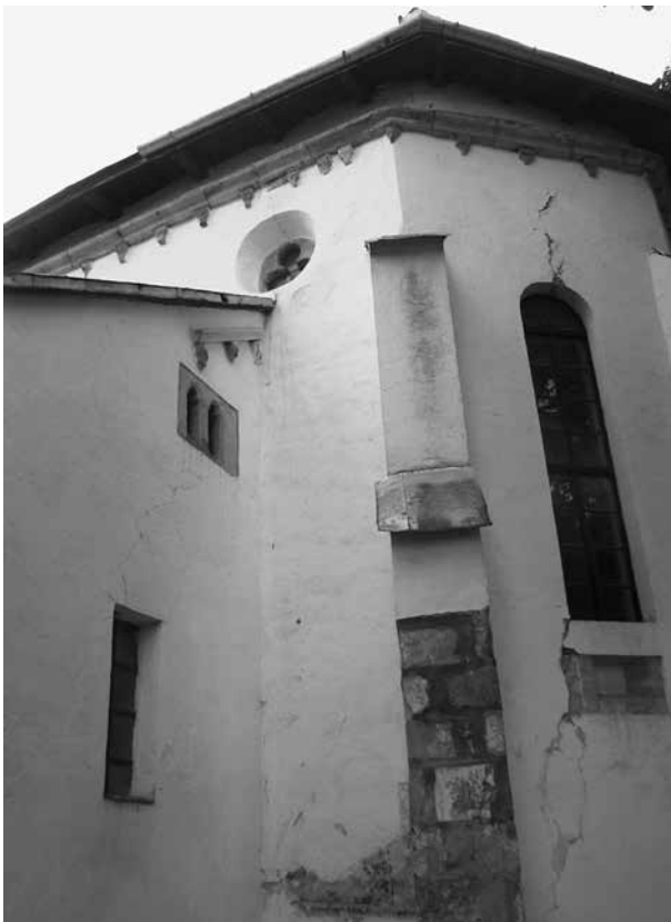
Abb. 132. Szék, Pfarrkirche, Chor, Ansicht von Südost (Foto: Pál Lővei)
