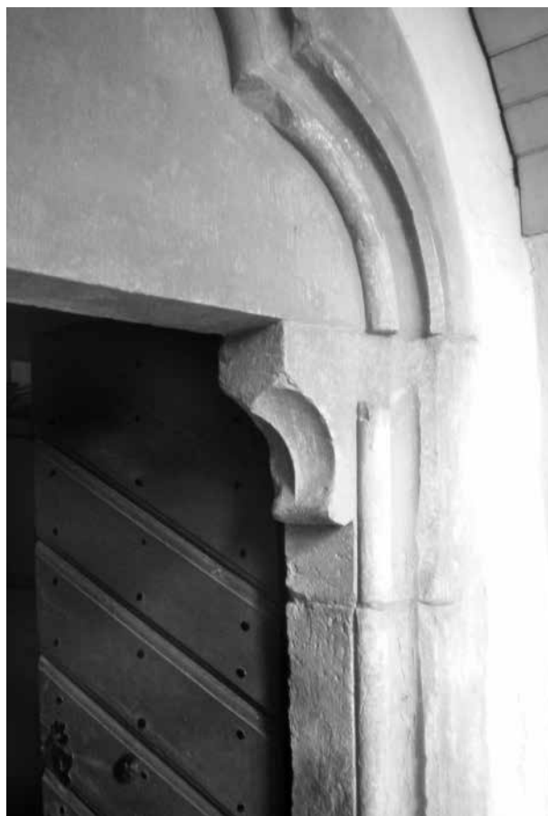
Abb. 123. Kerz, Westportal des Chors, Detail
