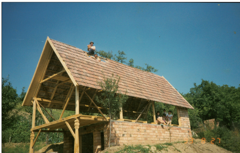
Az új pince építése
