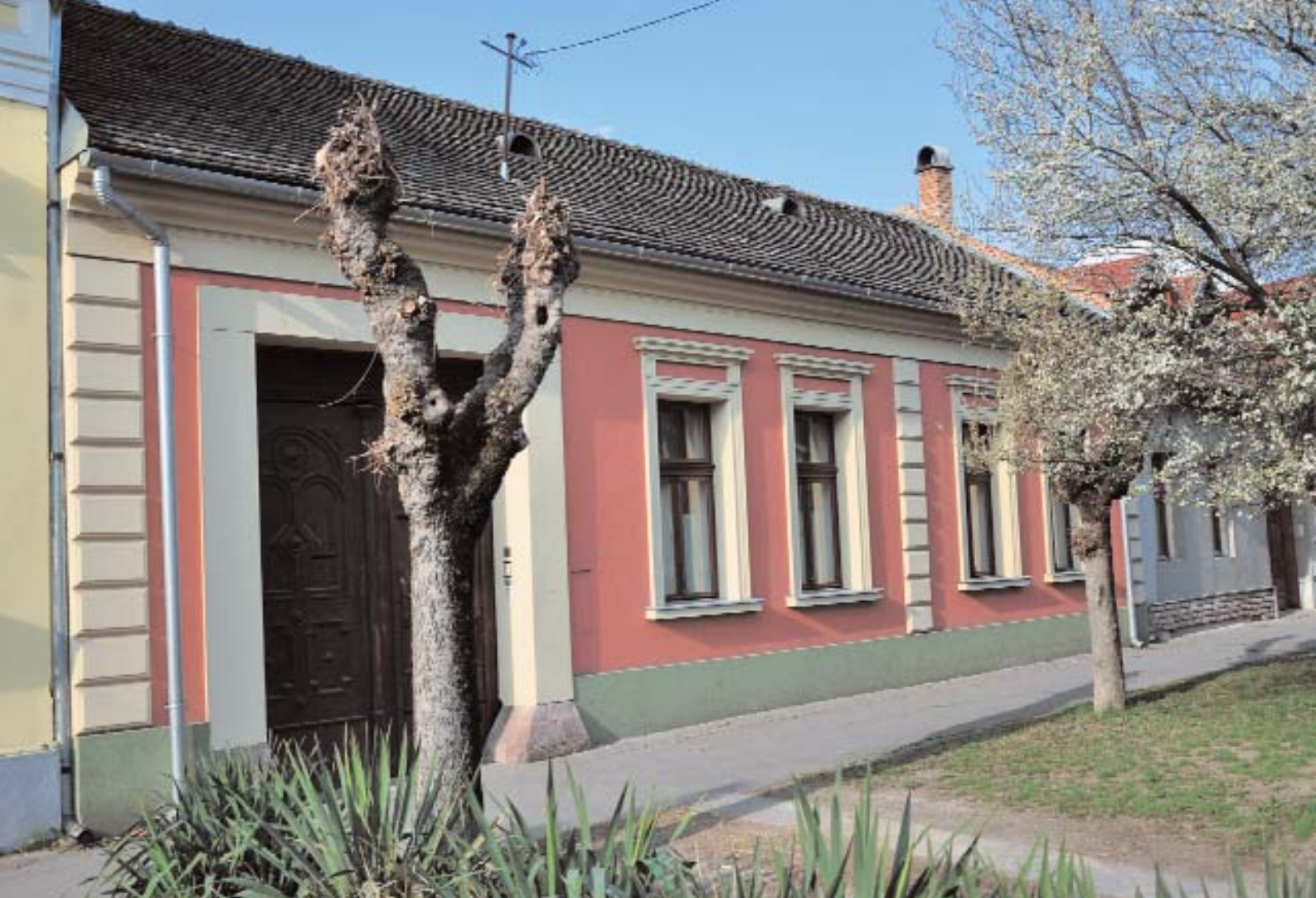
1. kép. Hőszigetelt, felújított utcai homlokzat részlete
