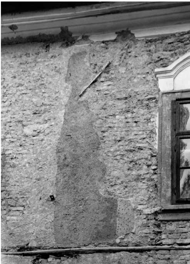
13. kép Kőszeg, Rájnis utca 10. 17. század végi nyílást keretelő függőleges vakolatdíszítés töredéke az utcai homlokzaton (Hulyák Anna felvétele, 1978; KÖH, MKDK Topográfiai Osztály)
