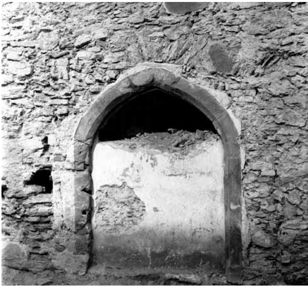
9. kép Kőszeg, Rájnis utca 10. A gótikus pincelejáró a terméskő falszövetben látható korábbi bejárat nyomával (Hulyák Anna felvétele, 1978; KÖH, MKDK Topográfiai Osztály)
