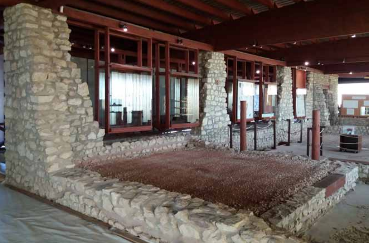
16. kép Felfalazások a helységek udvar felőli oldalán
