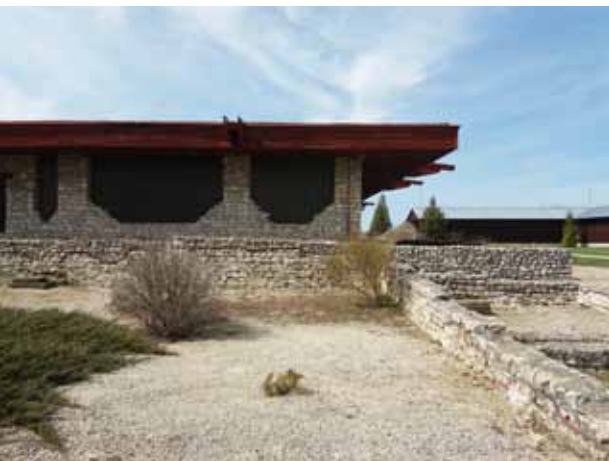
5. kép Biztos alapok, statikailag szükséges felfalazások, közöttük üvegpalló
