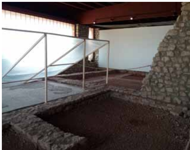
30. kép A tetőn keresztüli beázás ellen nyers szépségű installációk épületek
