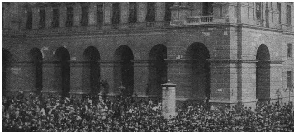
5. ábra. A rossz állapotú homlokzat részlete. Forrás: Vasárnapi Ujság 52 (1905. szeptember 24.) 39. 620
