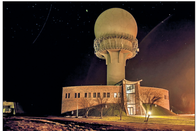
7. ábra. A medinai radarállomás már daruk nélkül, próbaüzemben
