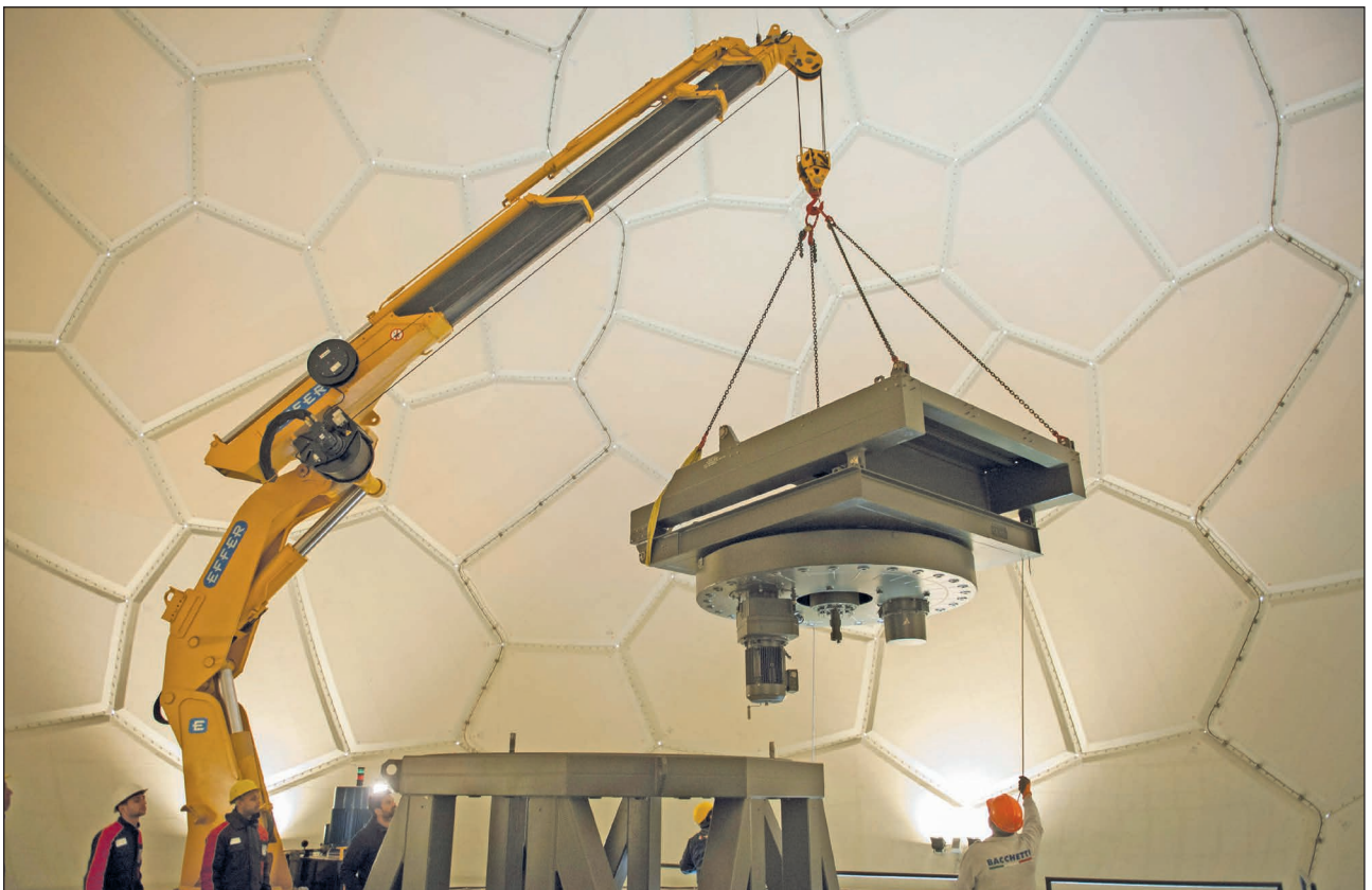
4. ábra. A radar beépítése a radomba
