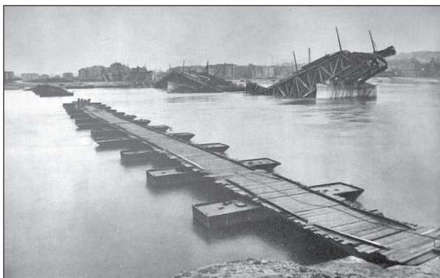
1. ábra. A „Manci híd” építése 1945 tavaszán, valószínűleg szovjet hídanyaggal
