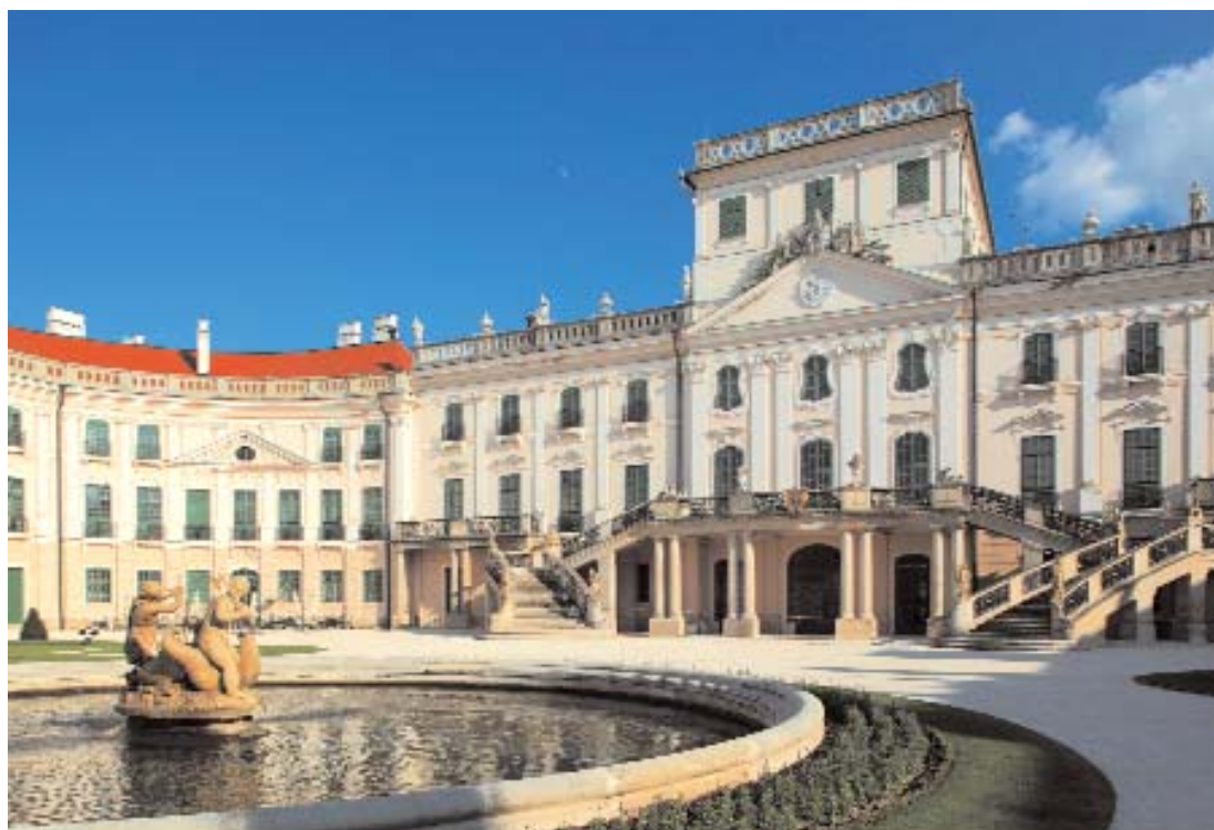
Fertői Esterházy-kastély felújítása több ütemben. A sokat vitatott homlokzat
