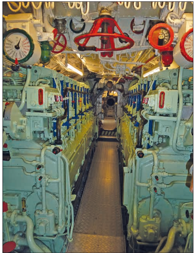
24. ábra. Az U 995-ös gépterme a két dízelmotorral. A dízelmotorjai 665 kW (kb. 905 LE-s) teljesítményt adtak le
